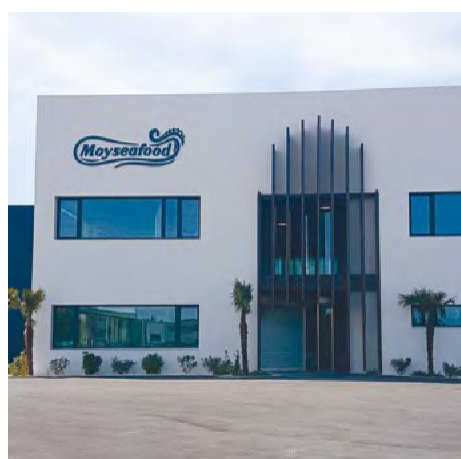
Encerramento de edifício industrial, Cádiz
